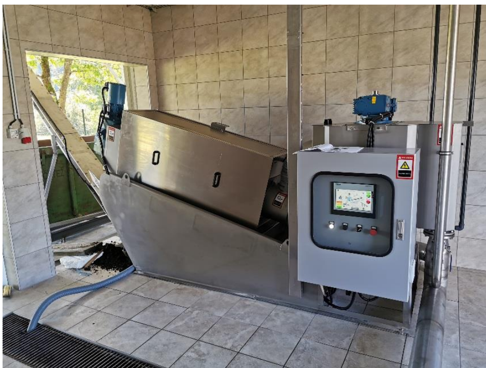
Slika 4: Nova počasi rotirajoča dehidracijska naprava
